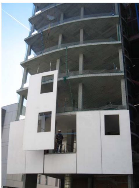
Proceso de montaje de los paneles.
