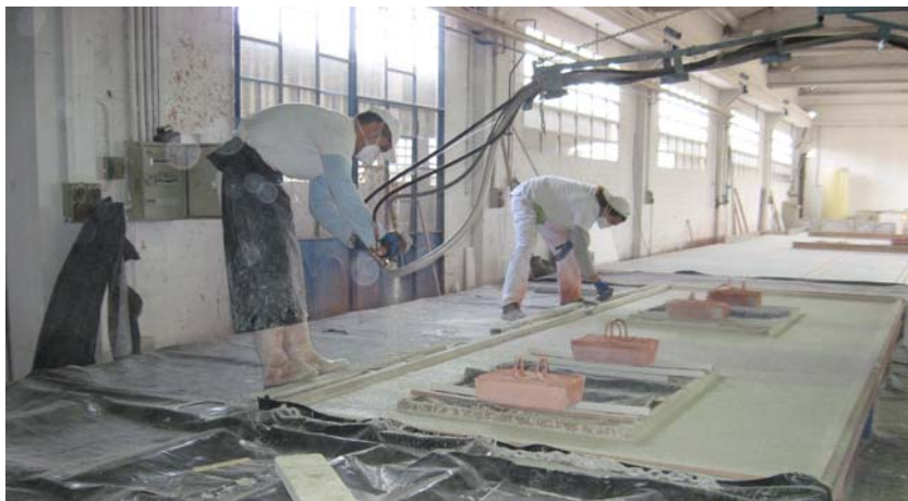
Proceso de fabricación de los paneles: proyectado.
